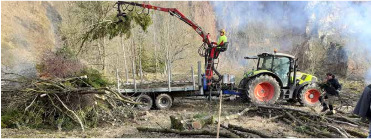
Arbeitseinsatz im stillgelegten Steinbruch Frohntal
