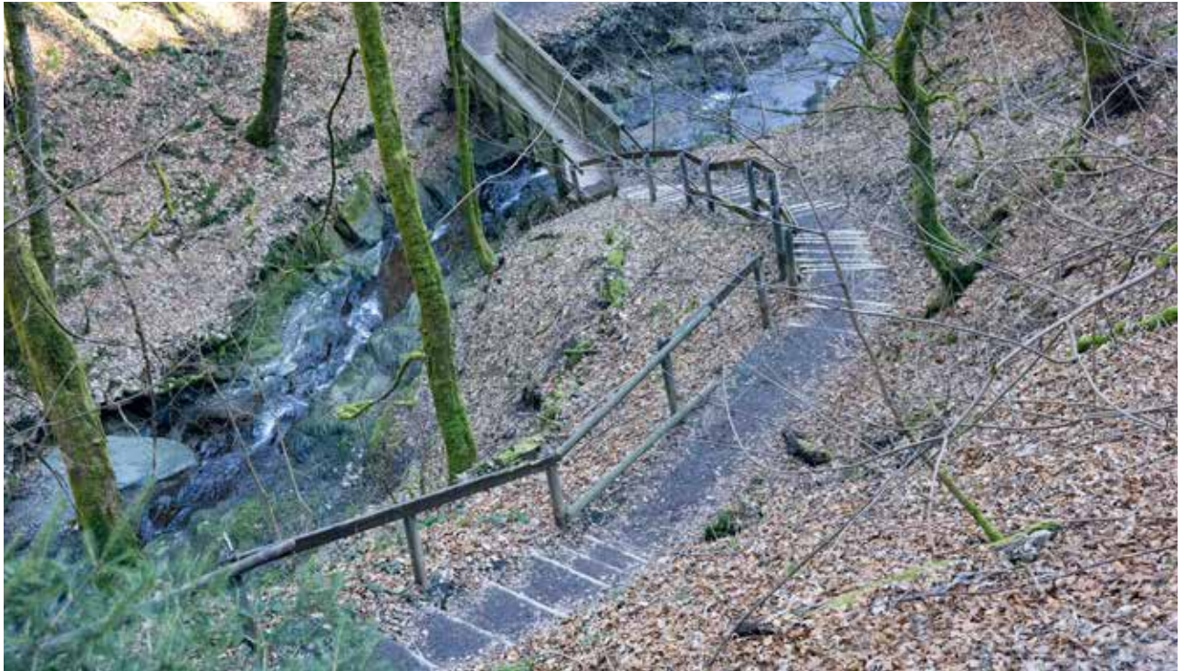
Die aufwendig verbauten und teilweise baufälligen Wegeabschnitte werden zurück gebaut.
